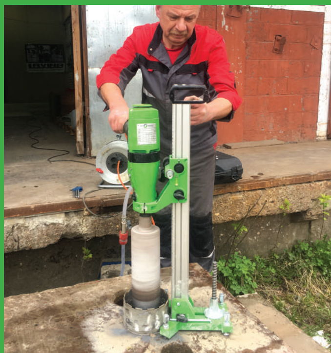
Вертикальное сверление железобетона
