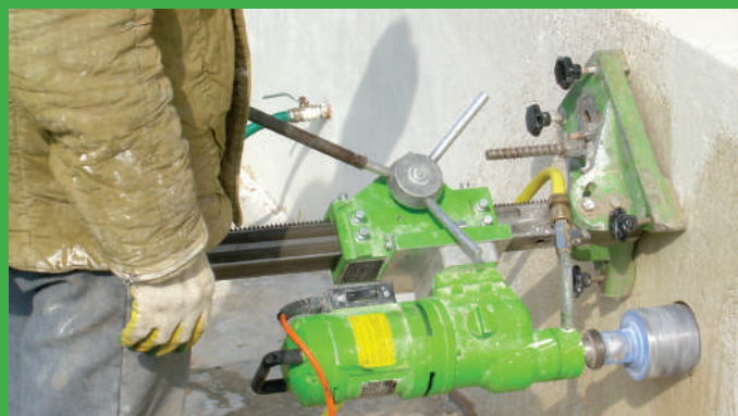
Горизонтальное сверление железобетона
