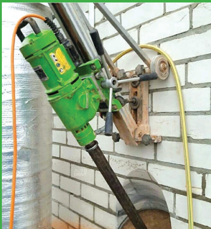
Сверление кирпичной стены под углом
