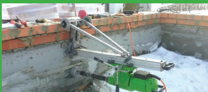
Сверление железобетонной стены
